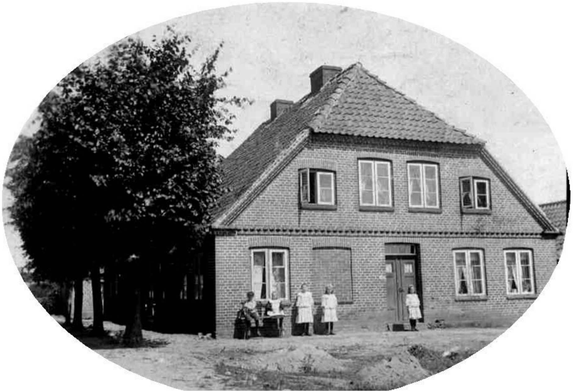
Böttcherei J. Stuth, erbaut vor 1871, rechts befand sich die Werkstatt (Parkstr. 17)
