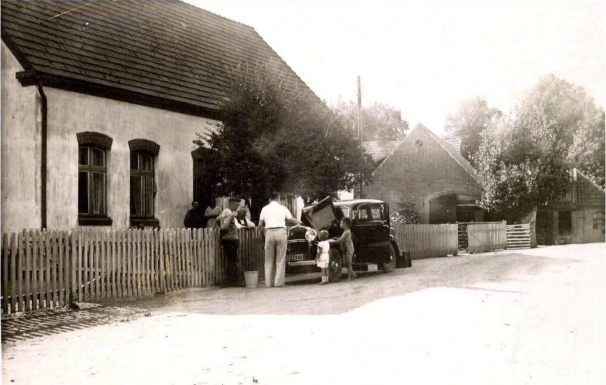
Tischlerei Sohns, erbaut um 1910, Besuch aus Hamburg mit Automobil (Parkstr. 2)
